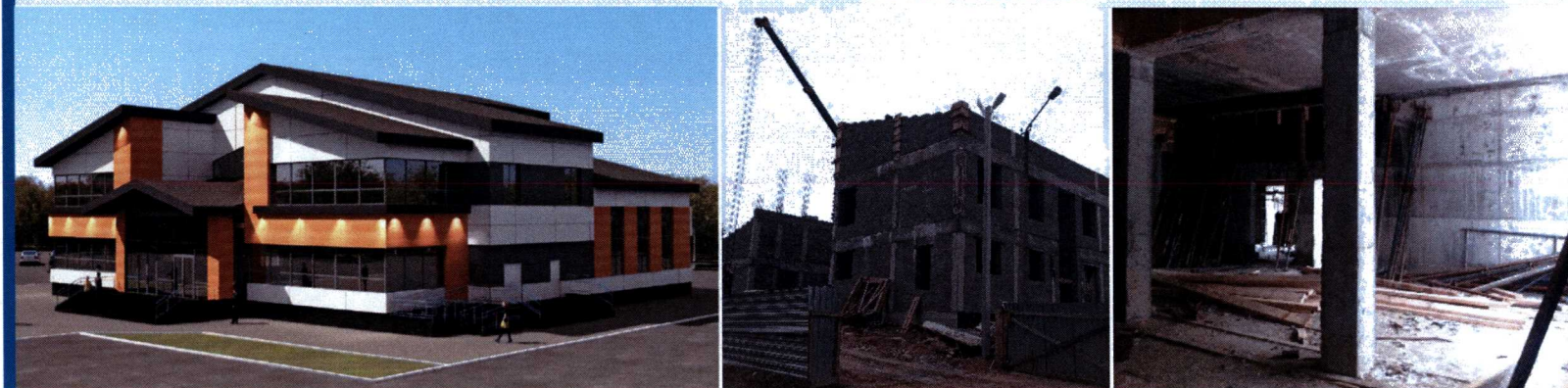
СТРОИТЕЛЬСТВО центра культурного развития в с. Ильинско-Подомское Вилегодского района
