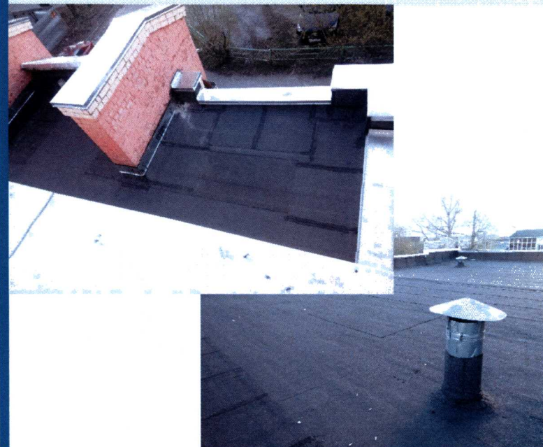
Капитальный ремонт кровли здания архива по адресу: г. Архангельск, ул. Октябрьская, 16
