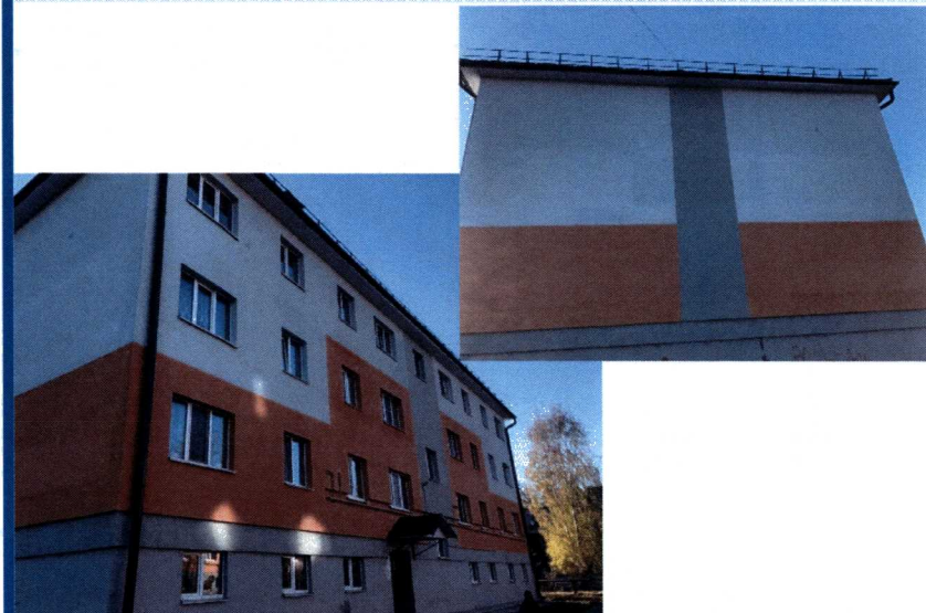
Капитальный ремонт жилого дома по адресу: г. Архангельск, ул. Вычегодская, 13, корп. 3
