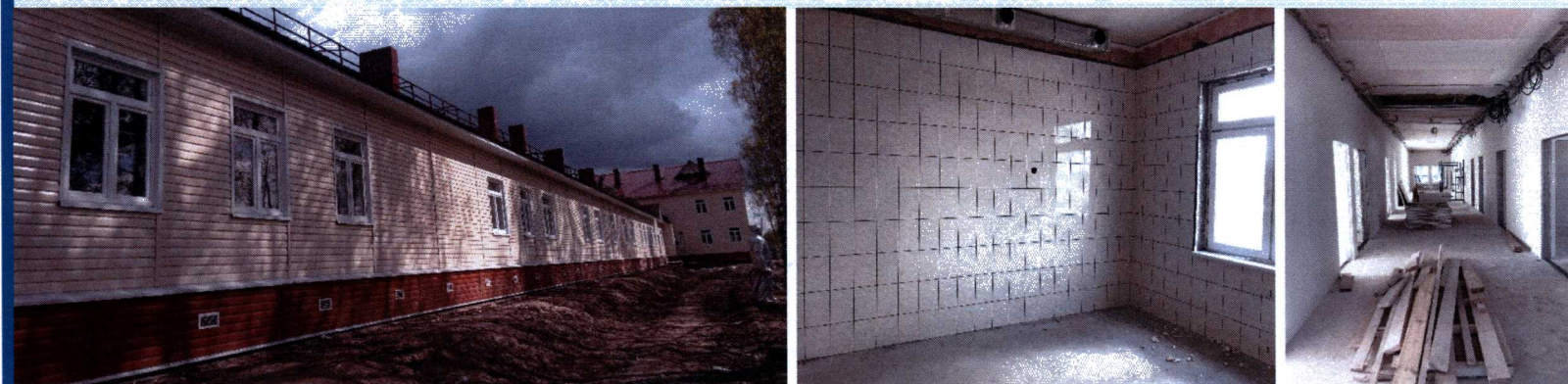
СТРОИТЕЛЬСТВО больницы в поселке Обозерский Плесецкого района
